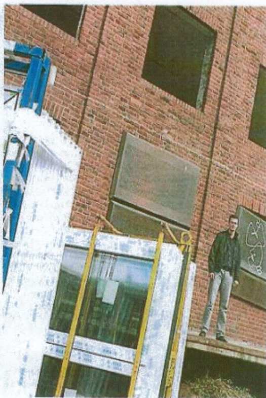
Die neuen Fenster sind schon eingetroffen. Bauherr Jan Rickel inspiziert die Baustelle. Foto: Edgar Daudistel
